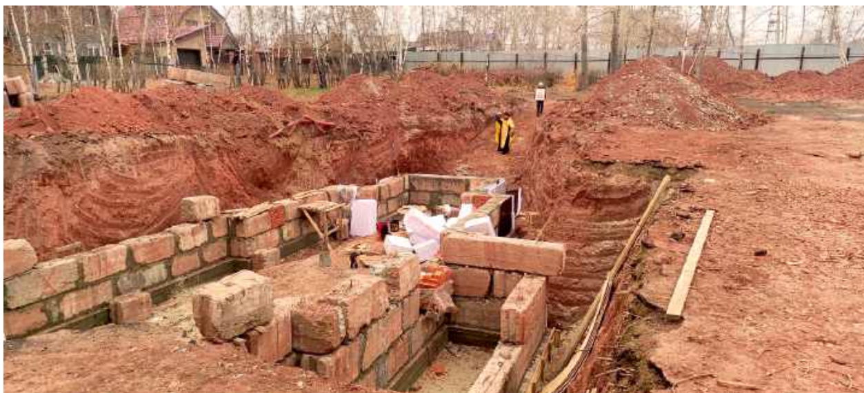
Место строительства храма. Окропление святой водой
